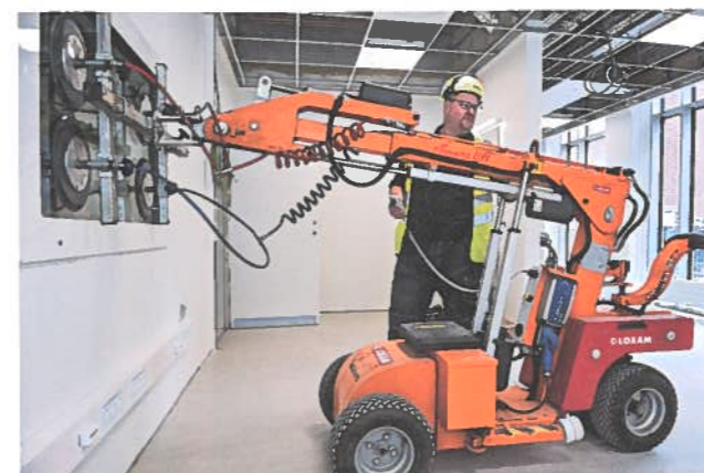
Inden tømrer Kim Bjørn Hansen bruger en sugeskop til at håndtere store elementer, er arbejdsgangen drøftet, aftalt og skrevet ned.
